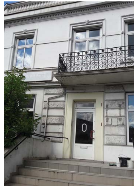
Die beiden Bilder zeigen die leerstehende Apotheke - hier ziehen demnächst Zahnärzte und Implantologen ein (Fotos: B.Schildt)
